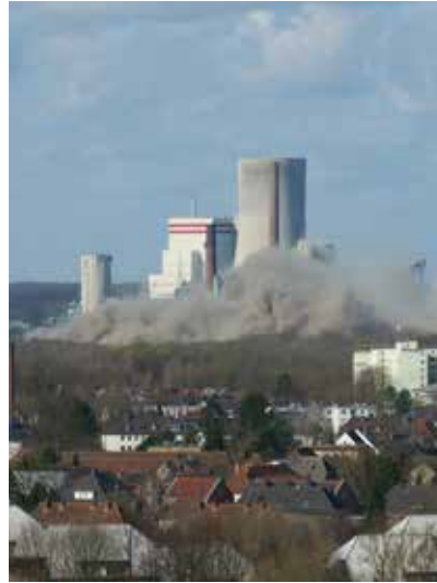
2021 wurde das STEAG-Kraftwerk Lünen gesprengt. Foto: Stadt Lünen
